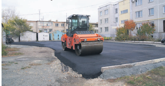
Асфальтирование дворовой площадки в центре п. Увельский
